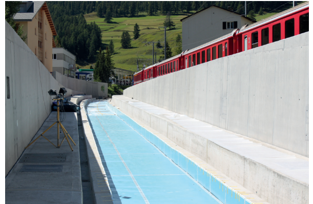
Teljes felületű masszív rugórendszer Sylomer®, RhB Samedan rendszerrel
